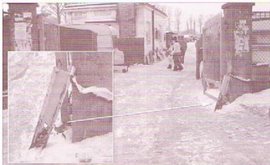
Brama Targowicy. Widoczne ubytki wypalone odpryskami pocisku wystrzelonego przez rosyjski czołg w dniu 16 stycznia 1945 roku
