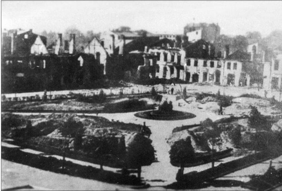
Widok na zniszczony Plac 3 Maja
