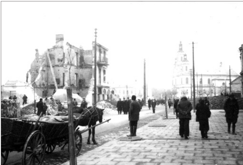
Rozbórka budynku przy ul. POW (obecnie ul. Krakowska)
