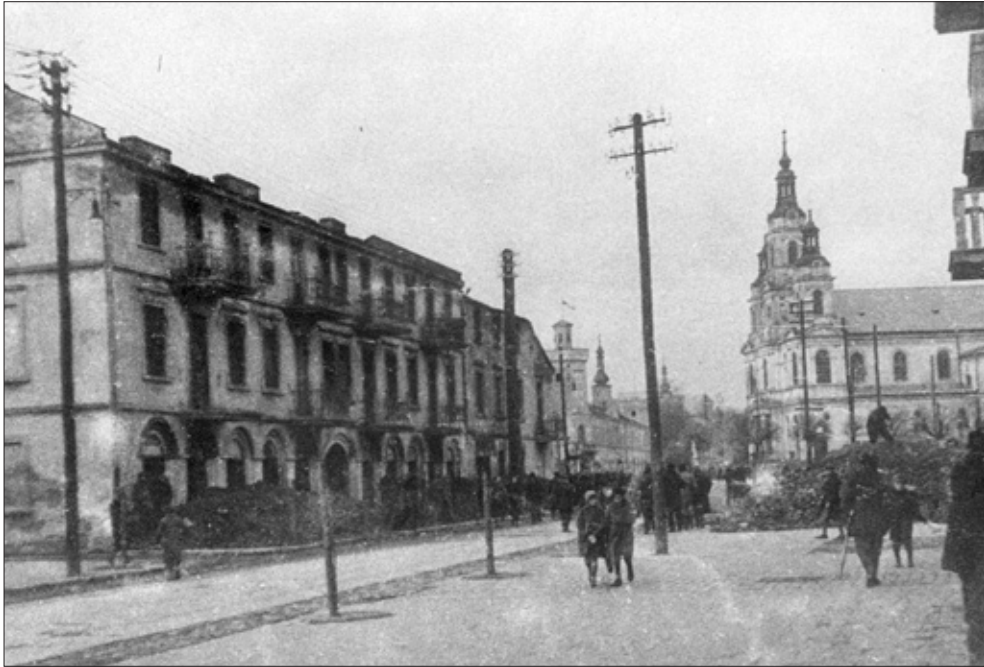
Od lewej kamienica u zbiegu nieistniejącej ul. Mineralnej i POW (obecnie ul. Krakowska)
